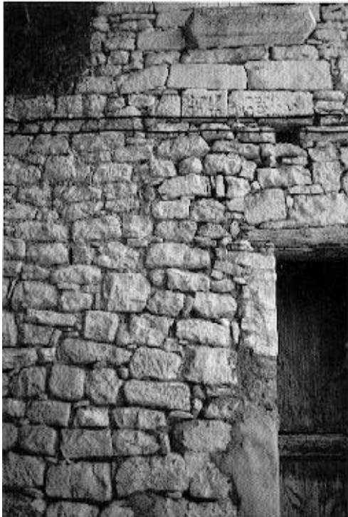
En la pared de esta casa de El Frago se utilizaron restos de lápidas de un cementerio judíos
