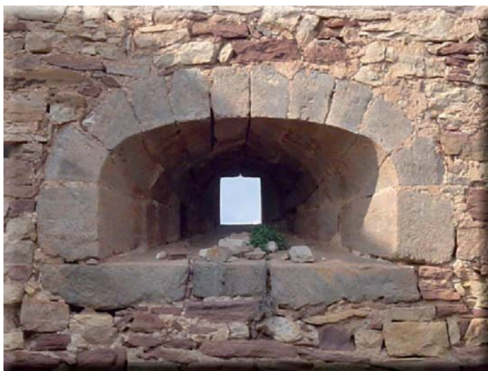
Figura 21: Castillo de Torres Torres (Valencia): vista externa de la gran cañonera. Con su cuidado arco carpanel dovelado y el orificio interno rectangular, es éste uno de los ejemplares de mayor belleza entre los conservados en la Península Ibérica. Su datación ha de recaer en el primer tercio del siglo XVI, aunque no exista constatación documental.
