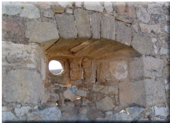
Figura 7: Castillo de Huesa del Común: vista exterior, ligeramente oblicua, de la tronera-cañonera.
