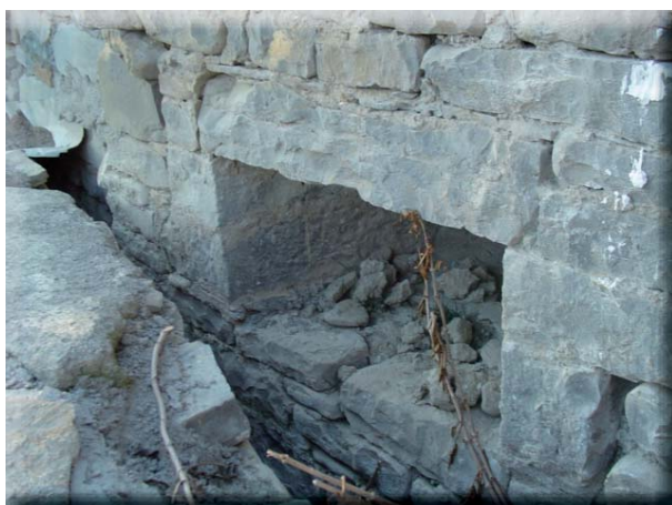
Figura 25: Palacio fortificado de Larrés (Huesca): vista exterior de una de las troneras de buzón situadas en la barrera. Presenta cierre adintelado, fuerte deriva a ambos lados y nulo derrame.
