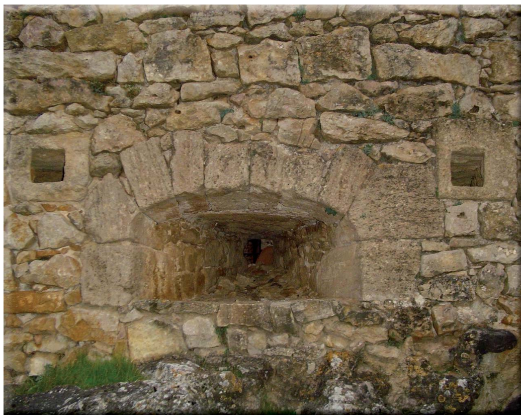
Figura 16: Fortaleza de Cardenete (Cuenca): vista exterior de una de las cañoneras de buzón. Se cubre con arco escarzano y posee un muy leve derrame. La embocadura interior del vano es de forma cuadrada. Los huecos cuadrangulares pequeños que se sitúan a ambos lados han sido interpretados de diversas maneras, no existiendo todavía unanimidad sobre su uso original. La obra, debida al Marqués de Moya, se estaba realizando hacia 1524, momento en que se interrumpen los trabajos.
