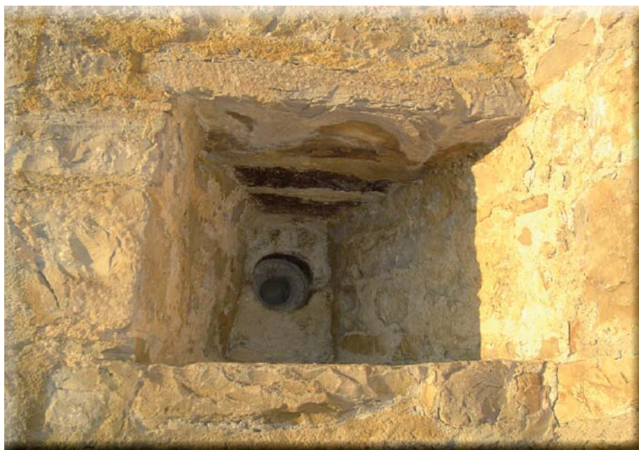
Figura 24: Palacio fortificado de Larrés (Huesca): vista exterior de una de las troneras de buzón situadas en la torre de flanqueo de la entrada cubriendo el acceso. En este caso el cierre es adintelado y apenas existe derrame; se observa claramente el orificio circular por el que se disparaban armas portátiles.
