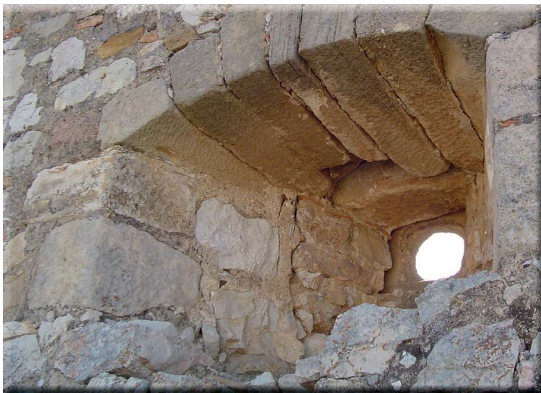
Figura 8: Castillo de Huesa del Común: vista exterior, contrapicada y ligeramente oblicua, de la tronera-cañonera.
