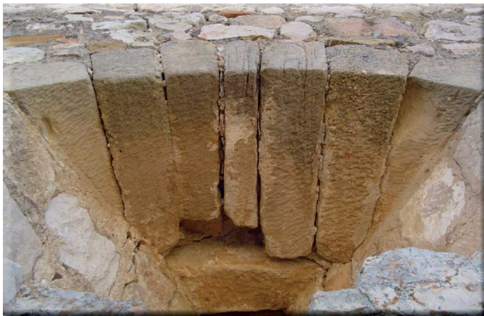
Figura 10: Castillo de Huesa del Común: vista desde abajo de las piezas que forman las dovelas y bóveda del nicho externo de la tronera-cañonera.
