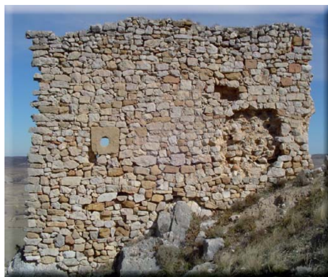
Figura 4: Castillo de Huesa del Común: interior del muro en que se abre la tronera-cañonera, observándose a la izquierda, a media altura, la abertura circular de ésta en una placa de piedra rectangular.
