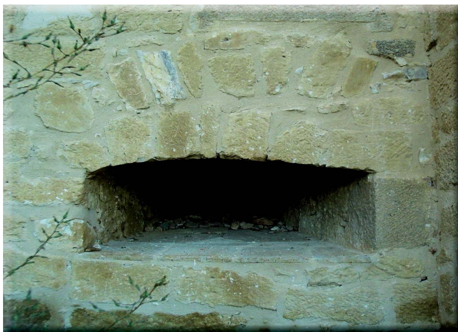
Figura 15: Castillo de Arévalo (Ávila): vista exterior de una de las cañoneras de buzón para tiro rasante situada en el nivel inferior. Presenta arco escarzano bastante bajo coronado por un tosco arco de descarga. La datación de la cañonera se ha de situar alrededor del período 1504 a 1517, fechas en torno a las cuales se realizó la construcción de la fortaleza por Fernando el Católico.
