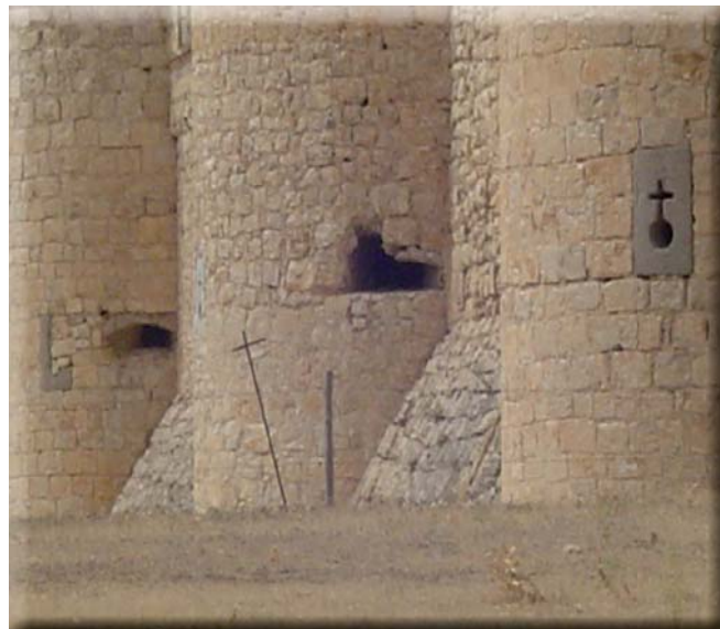
Figura 19: Castillo de San Silvestre (Toledo): vista de uno de los costados en que se pueden observar algunas de las troneras de cruz y orbe originales (segunda mitad del siglo XV) y las toscas cañoneras de buzón que fueron abiertas en una segunda etapa, probablemente en torno a la guerra de las Comunidades (1519-22).
