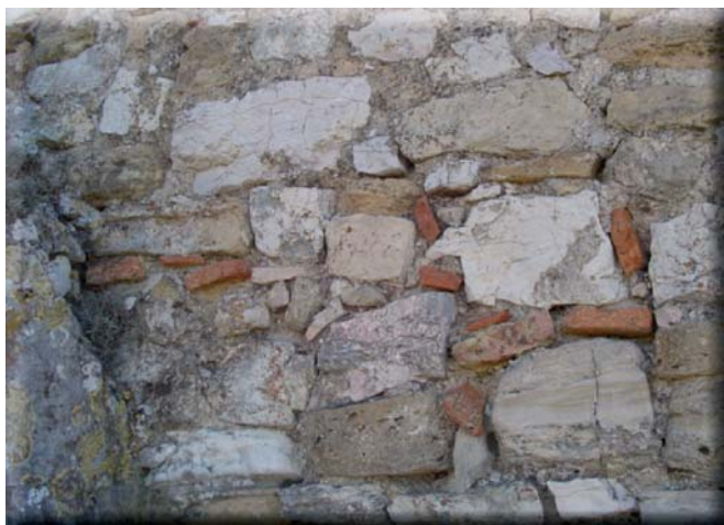
Figura 5: Castillo de Huesa del Común: detalle del paramento externo del muro en que se abre la tronera-cañonera mostrando fragmentos de teja y ladrillo insertos dentro de la argamasa de cal.
