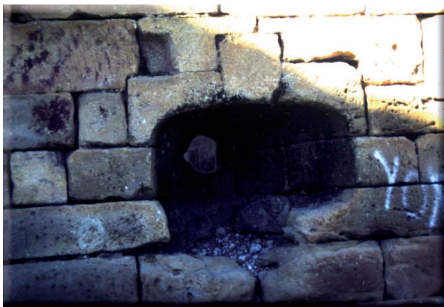
Figura 23: Palacio fortificado de Maella (Zaragoza): vista exterior de una de las troneras de buzón situadas a ambos lados de la puerta principal. Se trata de un ejemplar bastante refinado, que adopta una forma general de aspecto ovalado y se despieza en cuidadas dovelas; se puede ver la boca interna en cuidados círculo. Primera mitad del siglo XVI
