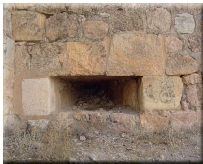
Figura 14: Castillo de Puebla de Almenara (Cuenca): vista exterior de una de las cañoneras para tiro rasante, con abocinamiento externo y arco adintelado de tres piezas. Datación hacia 1500 o poco después.
