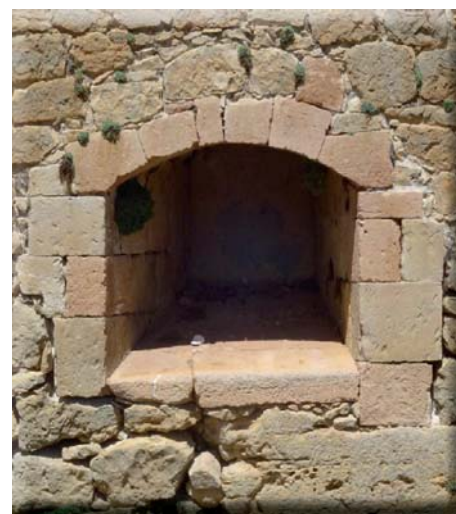
Figura 20: Castillo de Pedraza de la Sierra (Segovia): vista exterior de una de las cañoneras de buzón de la barrera, datables alrededor de 1530; la observación atenta permite establecer su apertura durante una reforma muy posterior a la construcción de la barrera, la cual pertenecería al momento 1439-1483. El vano, que aparece tapiado al interior, presenta arco escarzano dovelado, deriva discreta a ambos lados y potente derrame inferior.
