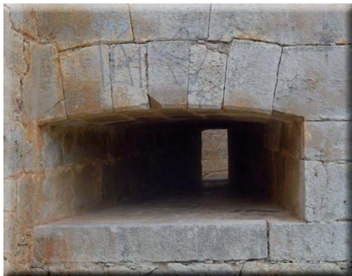
Figura 17: Castillo de Berlanga de Duero (Soria): vista exterior de una de las cañoneras de buzón situadas en la parte inferior de las torres circulares. Se aprecia el arco escarzano de dovelas bien labradas, el inexistente derrame y la embocadura interna del vano de forma rectangular. La fortaleza, añadida a la existente del siglo XV, fue realizada algo antes de 1528.
