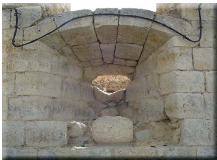
Figura 13: Castillo de Astudillo (Palencia): vista exterior de una de las cañoneras de la planta baja del cubo artillero, destinada al empleo de artillería ligera; posee abocinamiento exclusivamente externo, con lados rectos y remate en arco escarzano; la embocadura interna es ovalada; la zona inferior, que sería plana o con ligero derrame, permanece bastante dañada y muestra el añadido de una bola en
