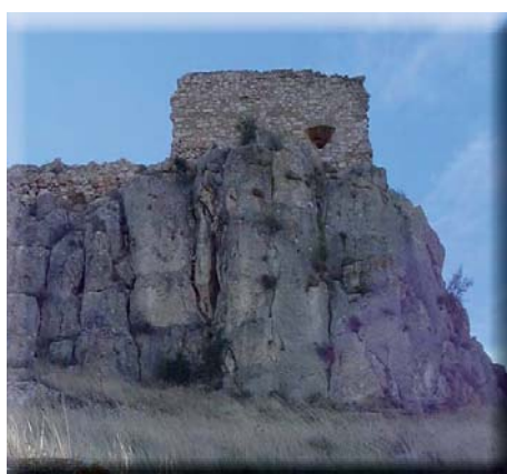
Figura 3: Castillo de Huesa del Común: vista desde el exterior del muro en que se abre la tronera-cañonera, encaramado sobre la roca que sirve de base al castillo.
