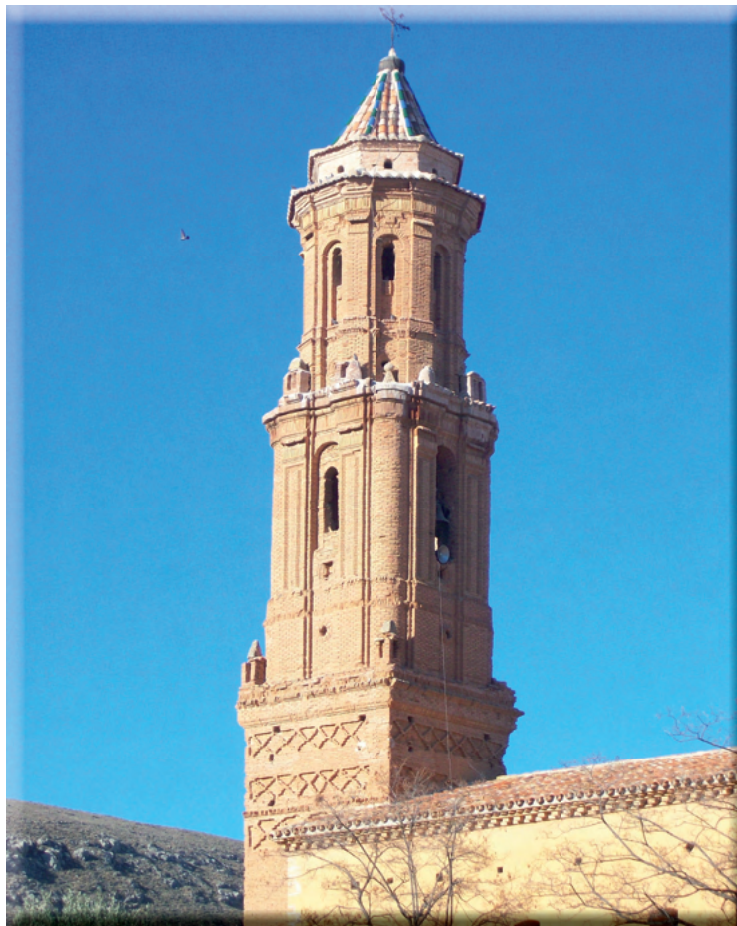
Torre de la Iglesia y chapitel en su estado actual
