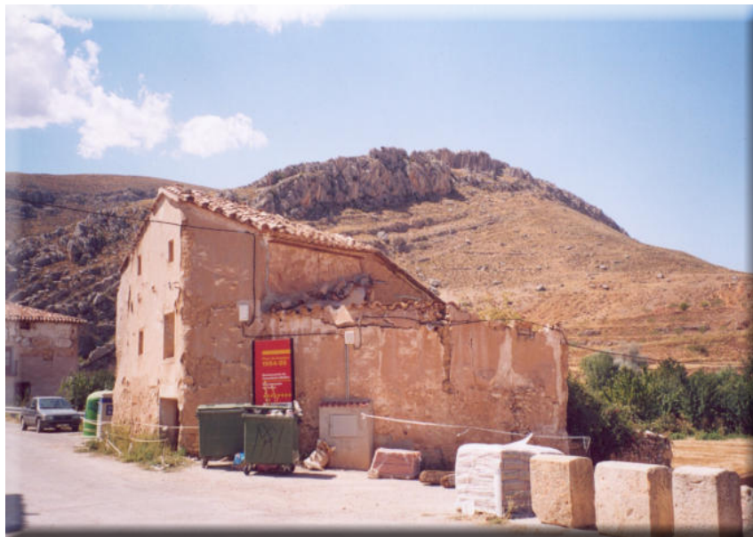
Lugar en el que estaba ubicada una de las torretas: en la carretera, frente a la fachada de esta casa ya desaparecida.
