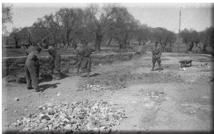
Soldados del Regimiento de Ingenieros reparando una carretera. Lugar sin localizar.
