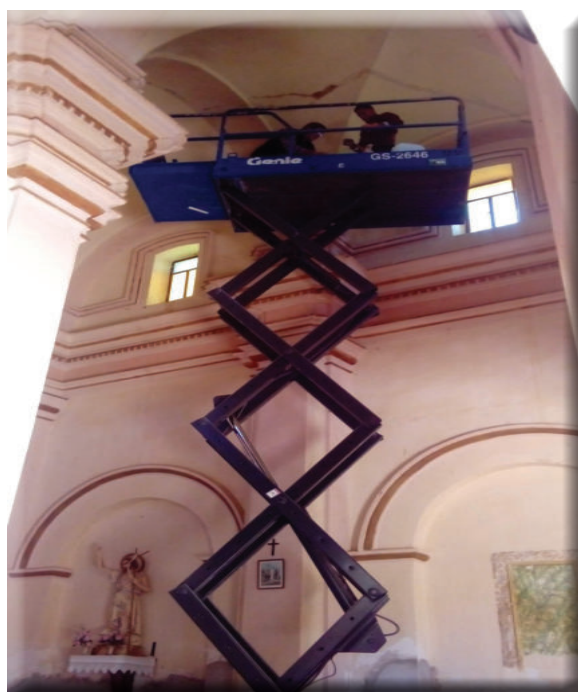
Reparaciones en Santa Quiteria
