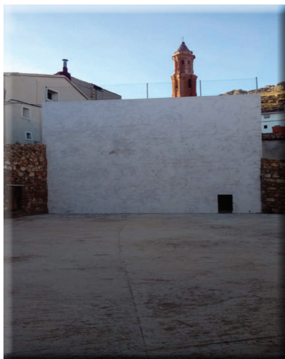
Reparación del Frontón Plaza Nueva.
