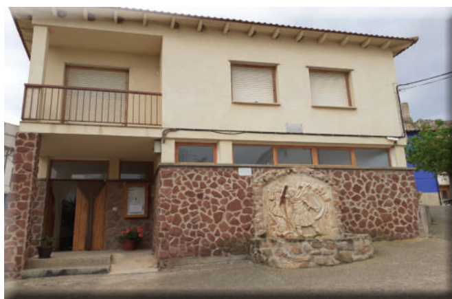
Aislamiento de ventanas en las escuelas y casa del médico.
