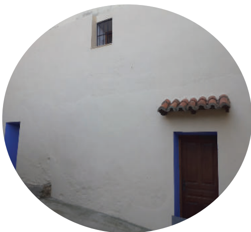
PINTURA DE LA FACHADA BAR TOLO
