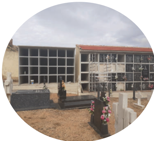
AMPLIACIÓN DE NICHOS EN EL CEMENTERIO
