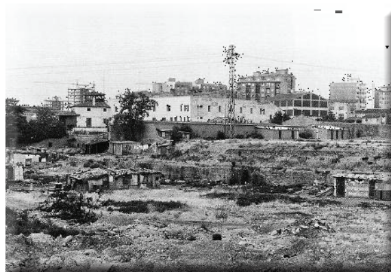
Vista del barrio de Las Fuentes de Zaragoza en pleno proceso de construcción. Desde el parque Torrerramona. C. 1968.
