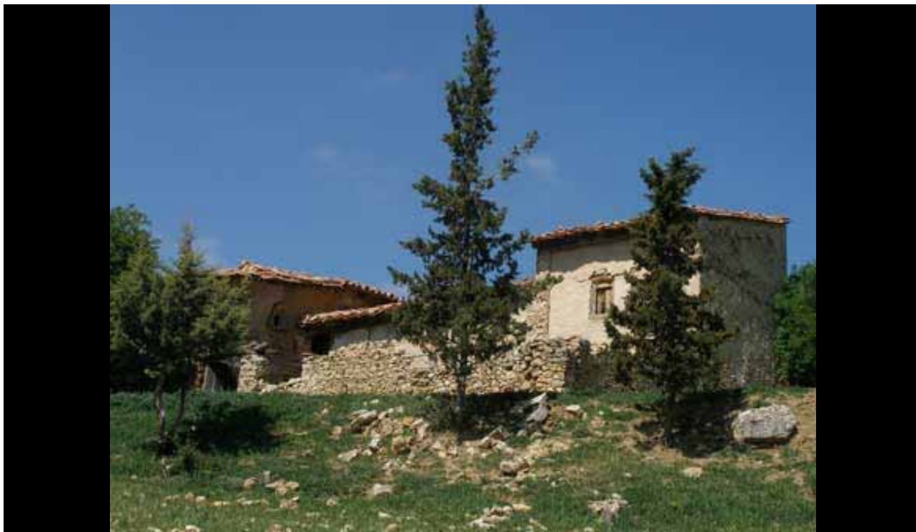
Masía de los Ordiales. Ejulve.
