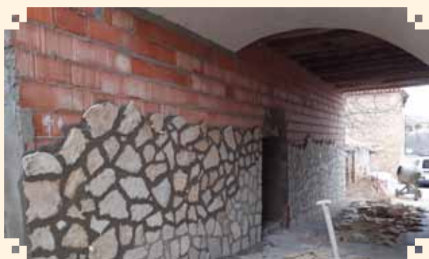
CALLE BARTOLO Obras de rehabilitación del Arco. Marzo 2023
