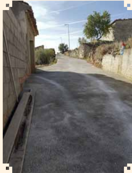
CAMINO DEL CEMENTERIO Acondicionamiento del camino desde la Iglesia hasta el cementerio.
