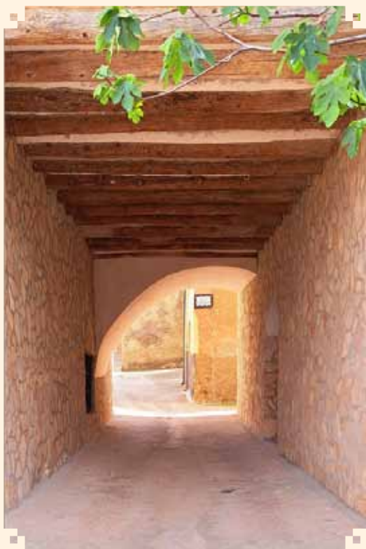
CALLE BARTOLO El Arco en la actualidad, una vez terminadas las obras. Marzo 2023
