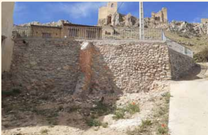
BARRIO ALTO Arreglos del muro del nuevo aparcamiento.
