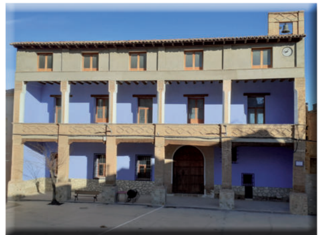
Fachada del Ayuntamiento en la Plaza Nueva Huesa del Común (2022)
