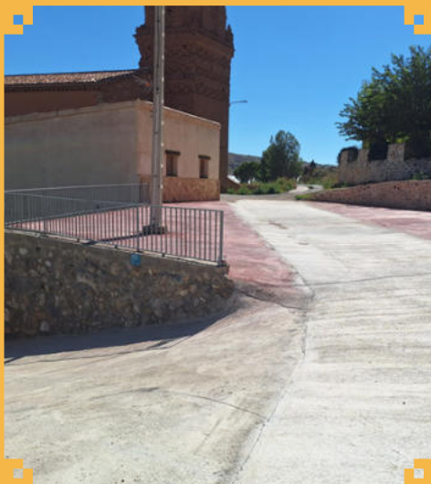
BARRIO ALTO Nueva pavimentación.
