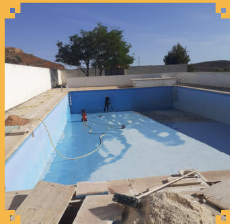
Obras de mantenimiento en la piscina municipal
