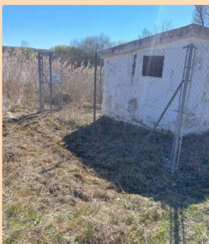
Limpieza de Yerna; operación imprescindible para garantizar el suministro de agua potable, y el acceso a las autoridades sanitarias para el control oficial del agua de consumo humano.
