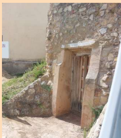
Reparación del rafe del nevero.
